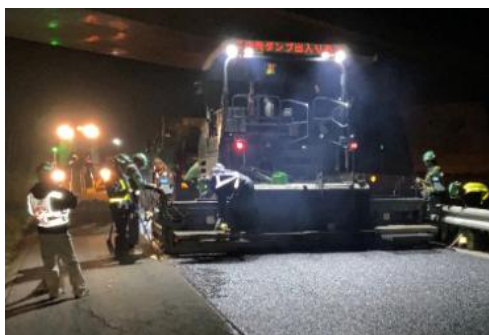
路面補修工事例
