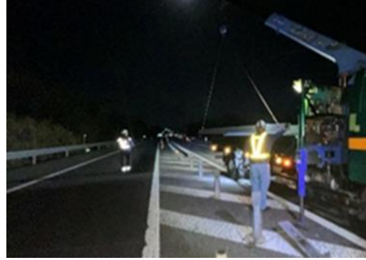
ボックスビーム撤去工 作業状況
