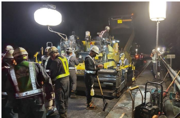
舗装補修工事
