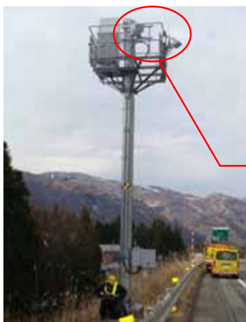
5.8GHzビーコンの取り付け状況
