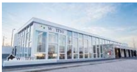
道央道 輪厚PA(上り線)
