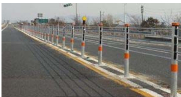
磐越自動車道(新津IC～新潟中央JCT)
