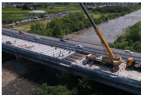
東北道 吾妻(あずま)橋床板取替工事
