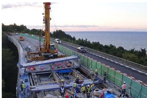
札幌道 大野橋床板取替工事
