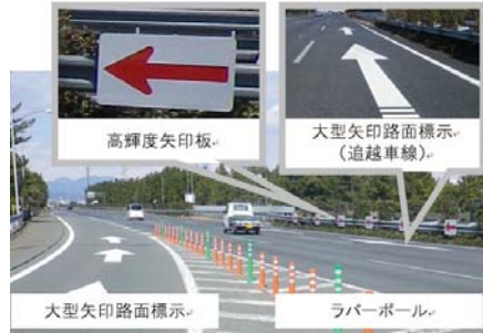
本線合流部対策 (全772箇所完了)
