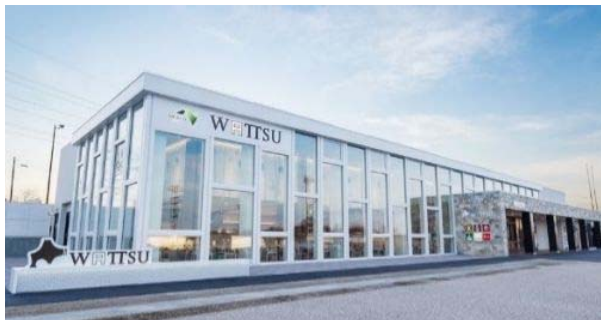
道央道 輪厚PA(上り線)
