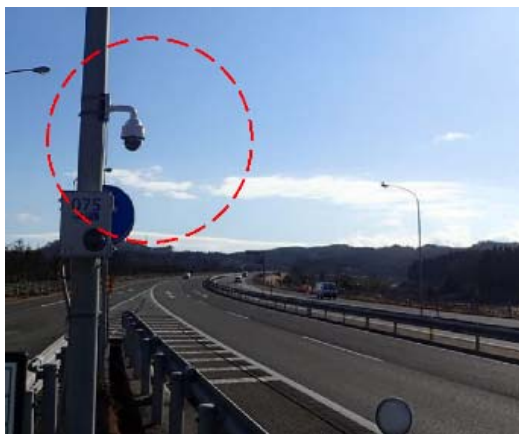
《監視カメラの設置状況》
