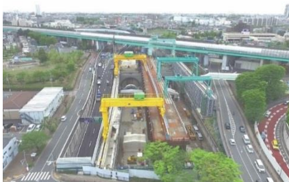
東京外環自動車道(大泉JCT)建設現場
