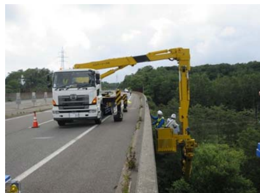
<構造物点検状況>
