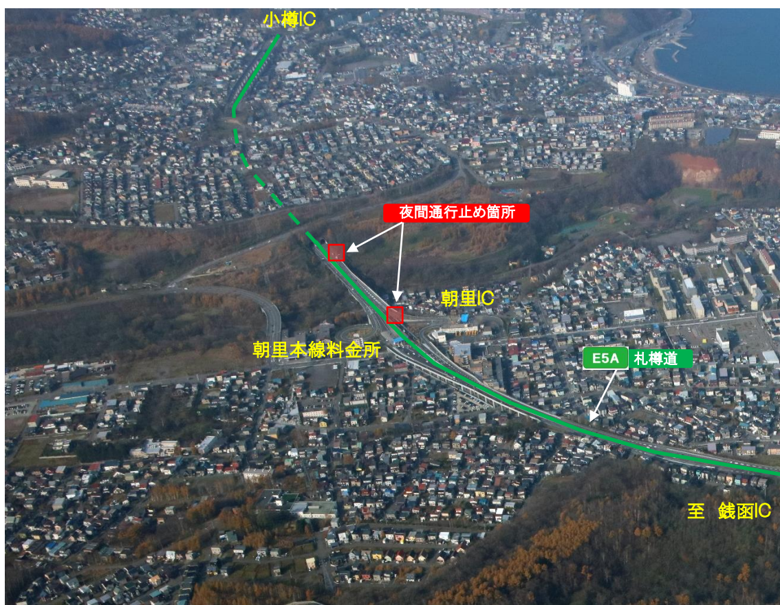
朝里本線料金所付近 航空写真(全景)
