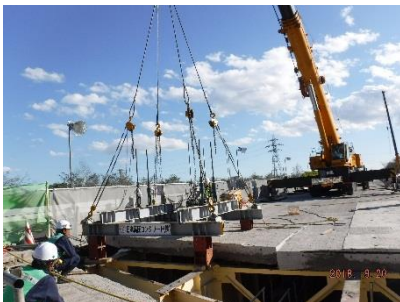
【コンクリート床版の撤去】
