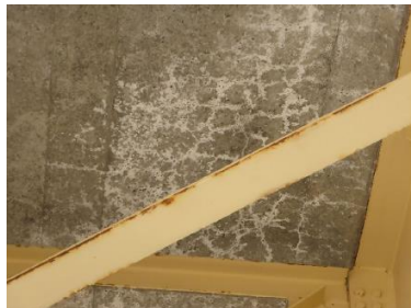
【床版裏面のコンクリートひび割れ状況(千歳川大橋)】
