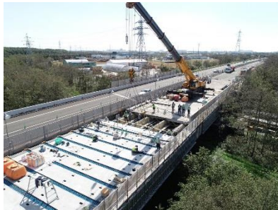
【新設コンクリート床版の設置】
