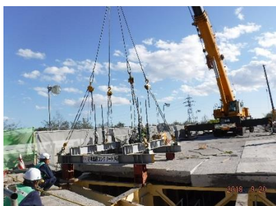
【コンクリート床版の撤去】
