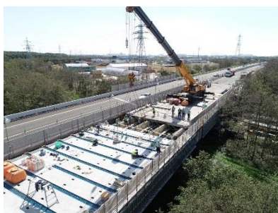
【新設コンクリート床版の設置】
