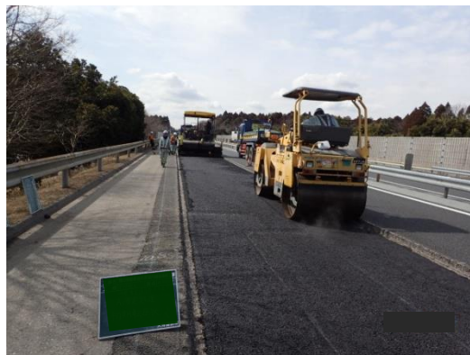
路面補修状況
