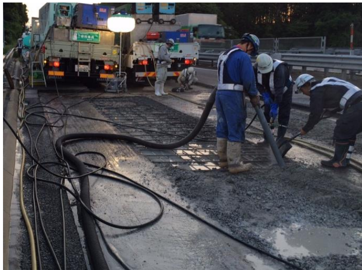
床版補修施工例
