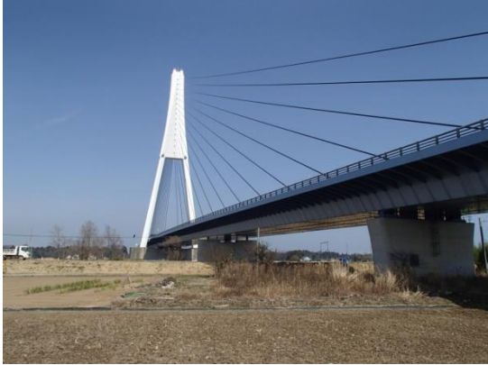
新那珂川大橋
