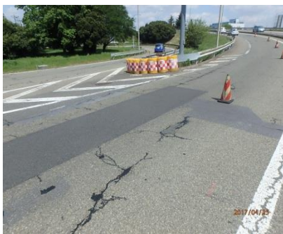
川越IC 現況舗装状況
