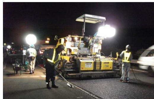
夜間舗設作業状況
