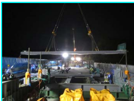
【新設コンクリート床版の設置】
