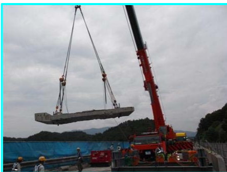
【コンクリート床版の撤去】
