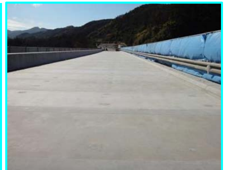
【新設コンクリート床版施工完了】
