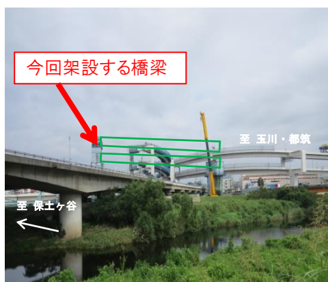
<橋架設位置現況写真> (第三京浜道路 港北IC付近より撮影)
