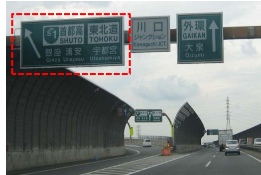
標識取替箇所
