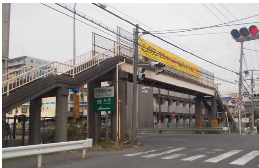
撤去を行う横断歩道橋(海神人道橋)
