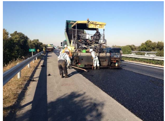
舗装補修工事 作業状況写真
