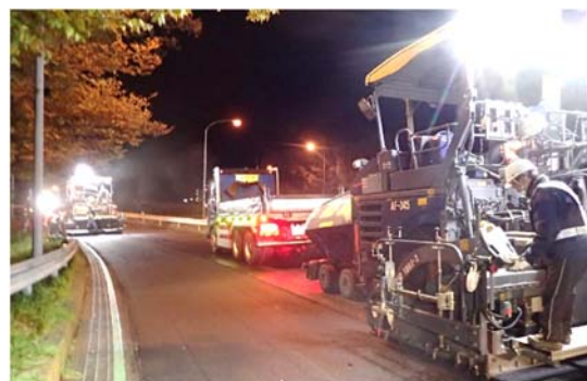
施工イメージ
