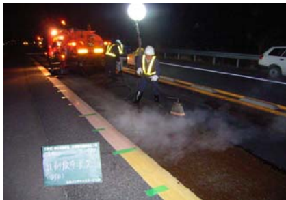
舗装補修工事
