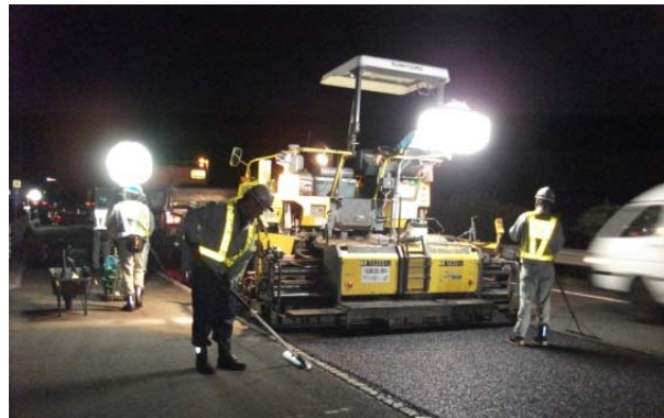
夜間舗設作業状況
