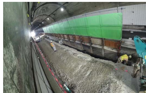
④ 埋戻し～仮舗装～規制解除
