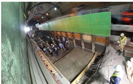
② 掘削～型枠～コンクリート打設
