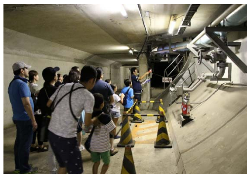
海底トンネル内の緊急避難通路
