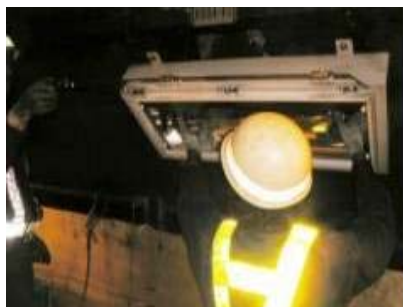
トンネル照明設備清掃点検写真
