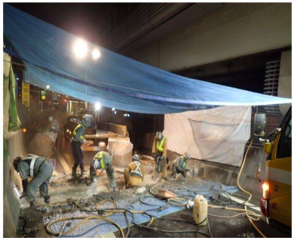
取替工事作業状況
