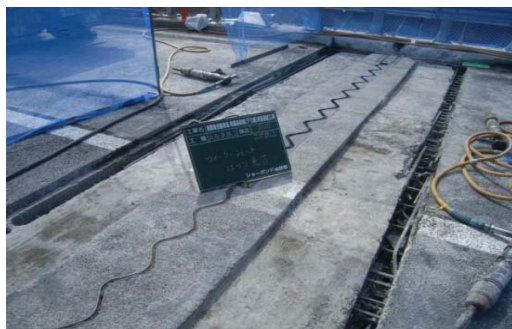
1.伸縮装置撤去
