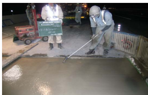
4.コンクリート打設
