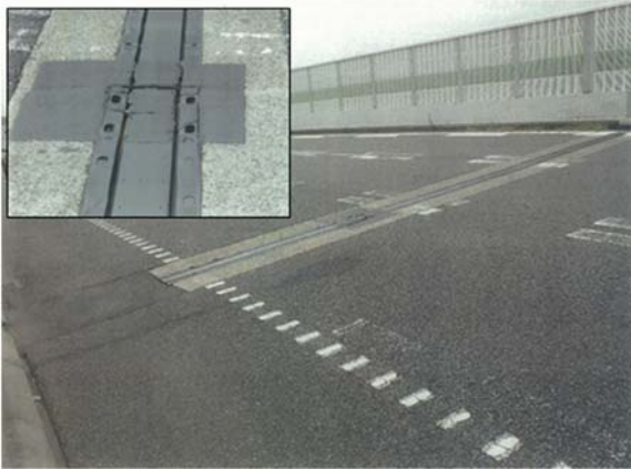
橋梁伸縮装置 現況写真
