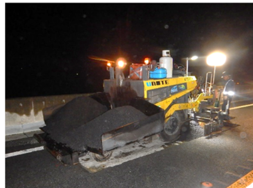
舗装補修工事
