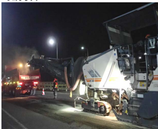
【アスファルト舗装切削状況】
