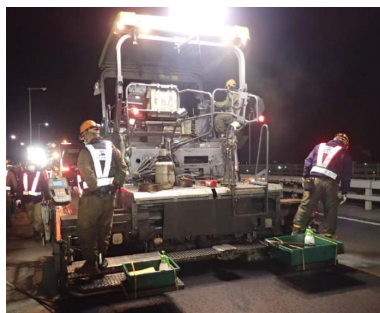
【アスファルト舗装施工状況】
