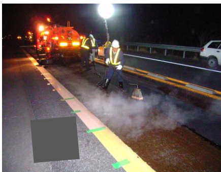
舗装補修工事
