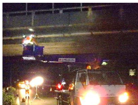
道路構造物の点検
