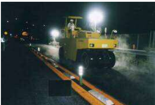
舗装工事作業状況
