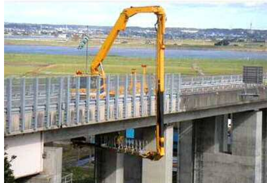
橋梁点検作業状況
