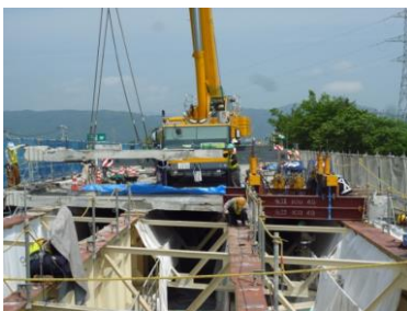
コンクリート床版の撤去
