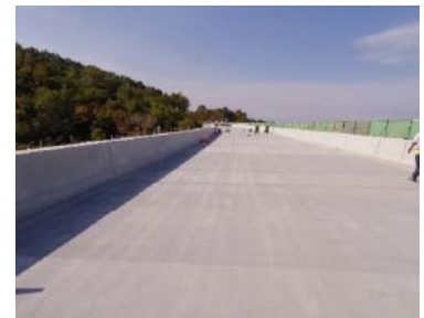
新設コンクリート床版の施工完了
