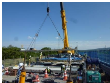
新設コンクリート床版の設置
