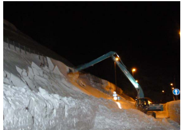
< 昨年の本線脇斜面の除雪状況 >
