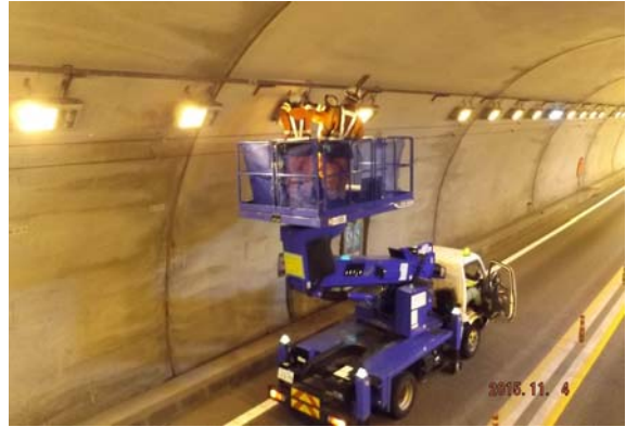
【トンネル内設備点検状況】
