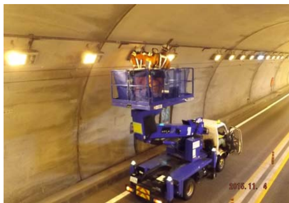
【トンネル内設備点検状況】
