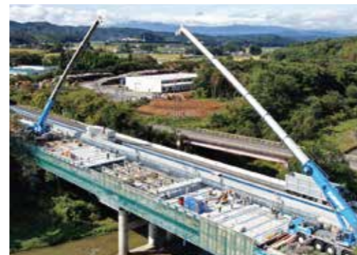
工事実施状況
