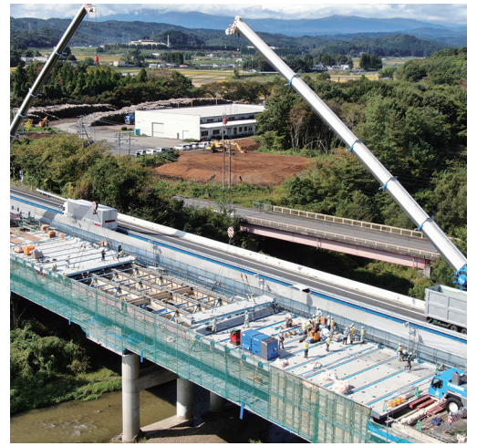
工事実施状況
