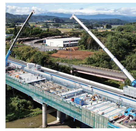
工事実施状況
