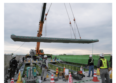
新しい床版設置状況
