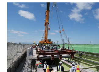
古い床版撤去状況
