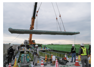
新しい床版設置状況
