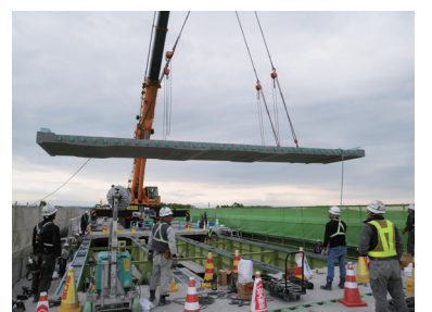
新しい床版設置状況
