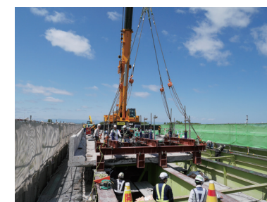
古い床版撤去状況
