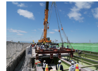
古い床版撤去状況
