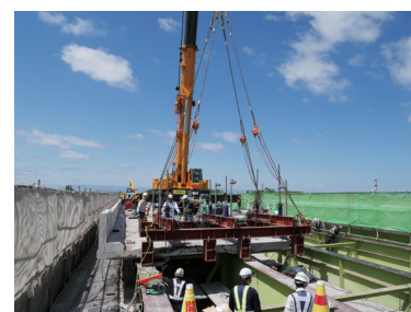
古い床版撤去状況
