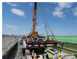
古い床版撤去状況
