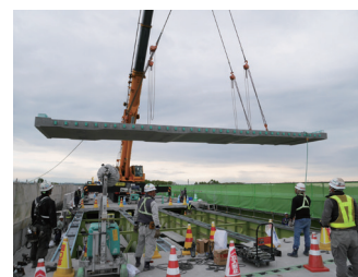
新しい床版設置状況
