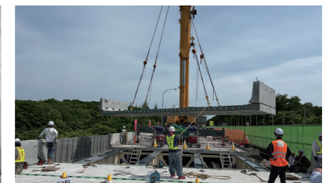
新しい床版設置状況
