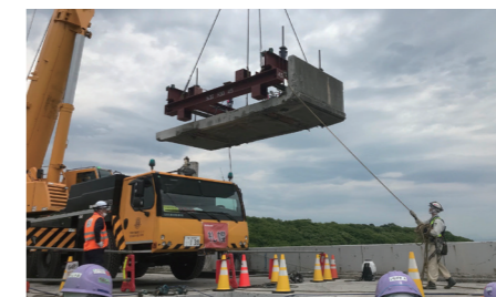
古い床版撤去状況
