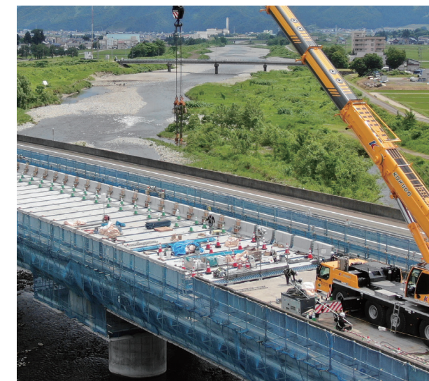
工事実施状況
